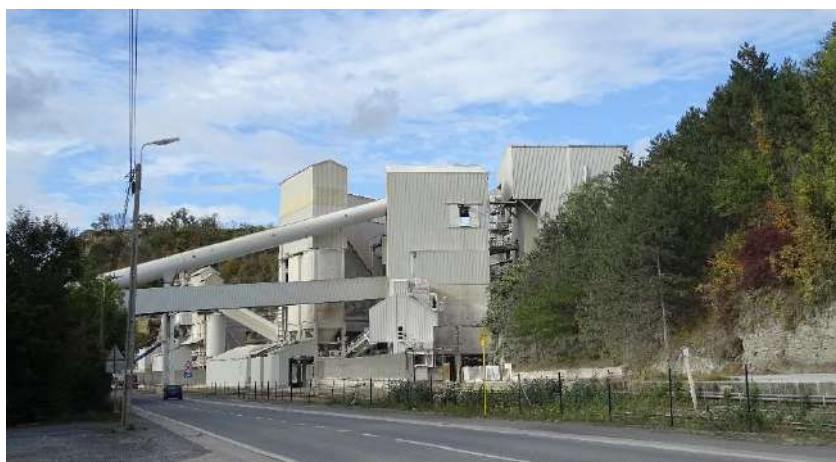
Photo 22 : Infrastructures de Carmeuse, P. Auriol, 2019
