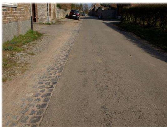
L'aménagement simple des filets d'eau maintient le caractère rural du centre du village
